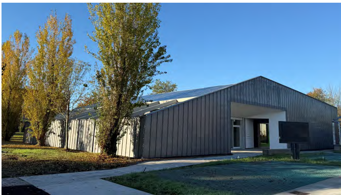
Figura 3 - Ingresso Smart Hub sito in Via Rochdale 1, adiacente alla sede legale
